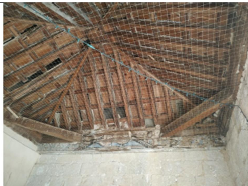
FOTO 8. Armadura de estancia de galería porticada.
