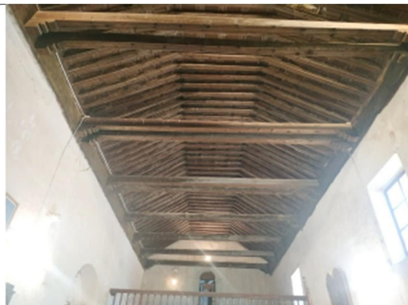
FOTO 7. Armadura de cubierta de nave principal interior.
